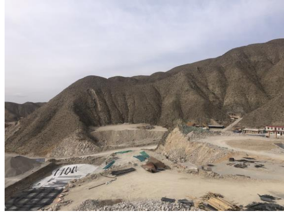
图 2-2 在建工业广场
