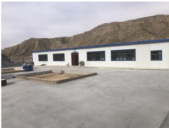
照片 2-7 生活区餐厅
