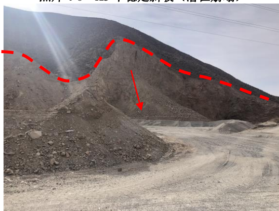
照片 4-8 X5 不稳定斜坡（潜在崩塌）
