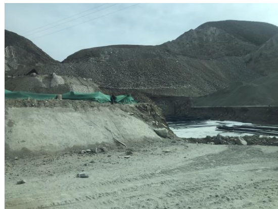
照片 4-12 采场挖损现状
