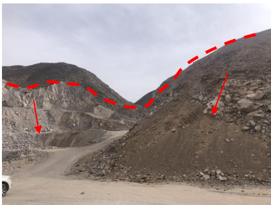
照片 4-5 X2 不稳定斜坡（潜在崩塌）
