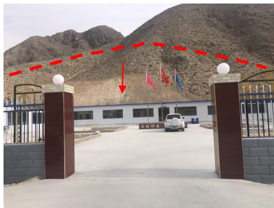
照片 4-10 X7 不稳定斜坡（潜在崩塌）
